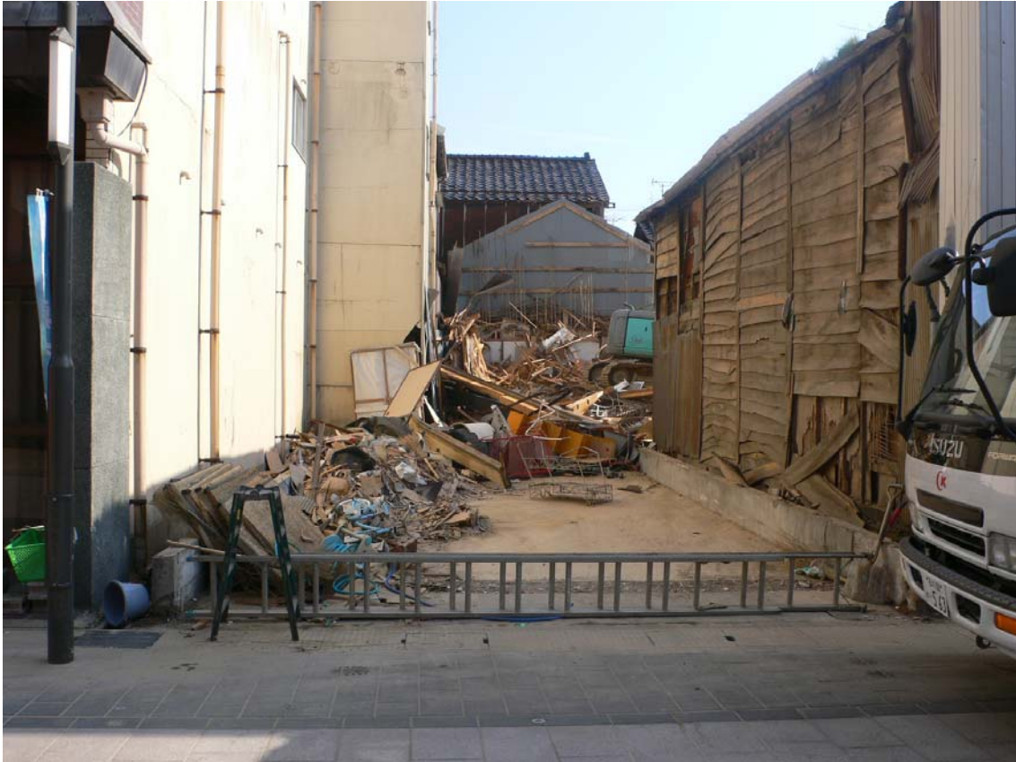
写真7 解体の進む被災建物（輪島市）
