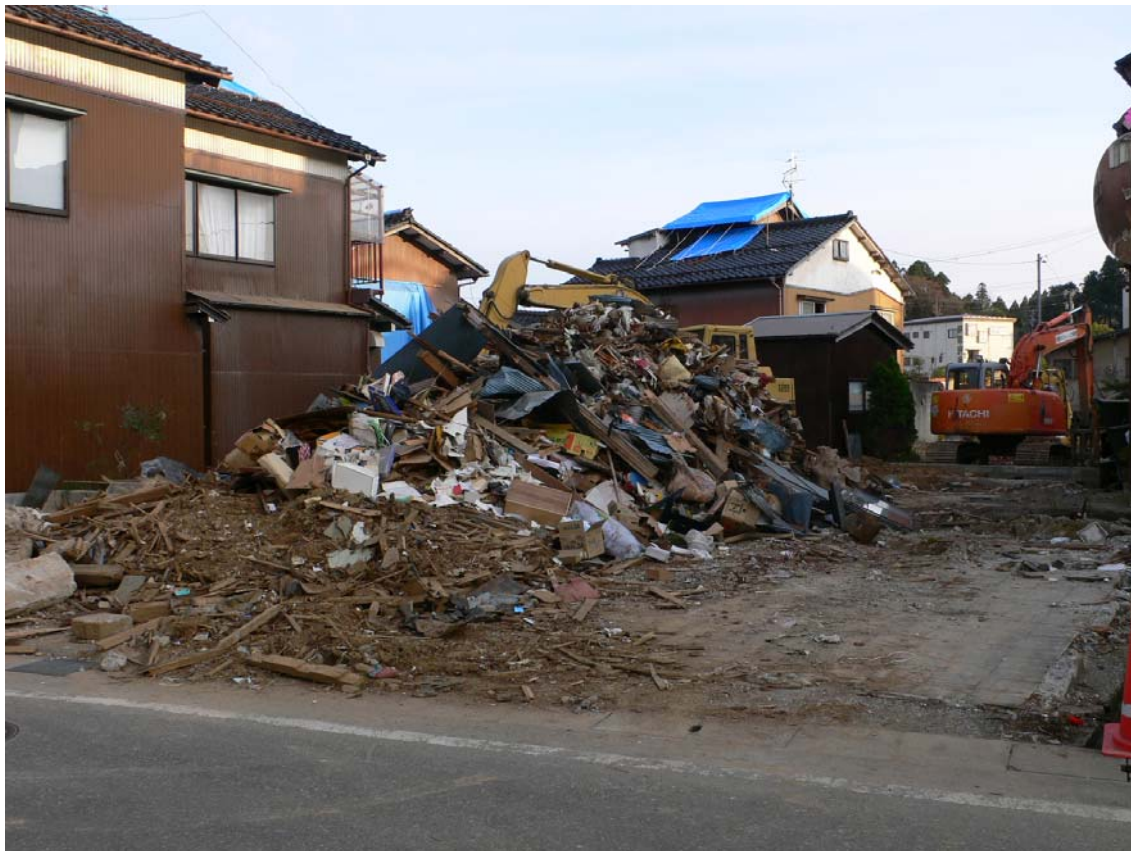
写真3 解体作業が進む被災建物（穴水町）
